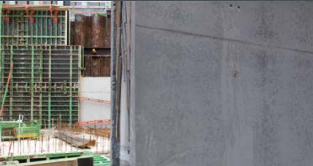
**RS Special, geölt** für porearme Betonoberflächen mit erhöhter Randbetonfestigkeit. Sie ist für den Einsatz im Kläranlagen-, Wasserbehälter- und Brückenbau geeignet.
