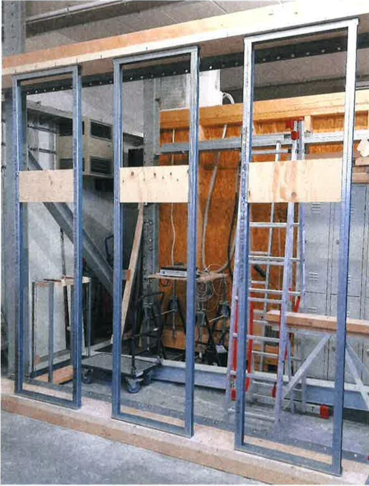
Abbildung A 1 Aufbau Metallunterkonstruktion inkl. Sperrholztraversen
