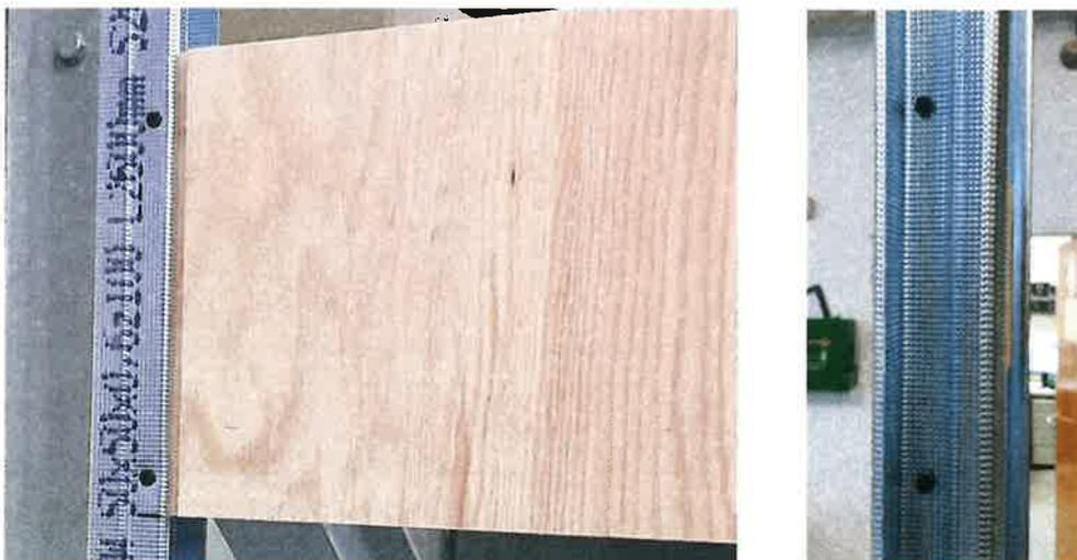
Abbildung A 2 Linkes Bild: Zweifache Befestigung einer Seite der Traverse durch den Flansch der CW-Profile,
